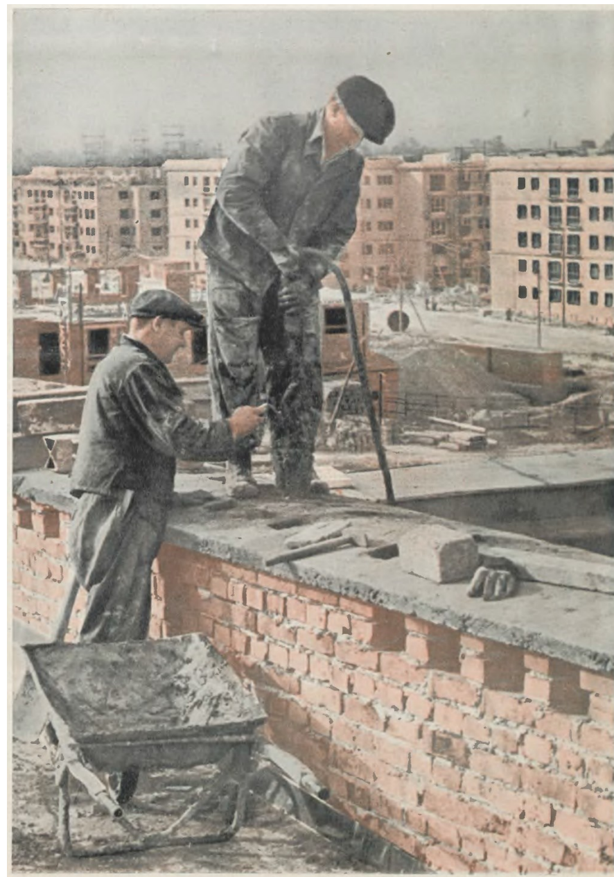
Il. 23. Budowa osiedla Muranów, "Stolica" nr 21 (236), 1951
