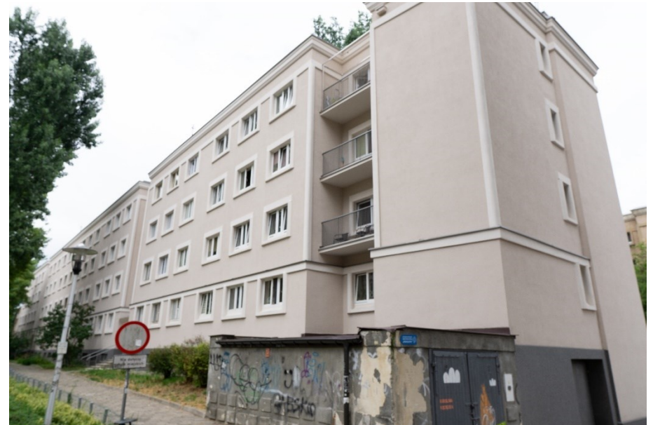
Fot. 20 ul. Nowolipie 25, widok od strony drogi wewnętrznej
