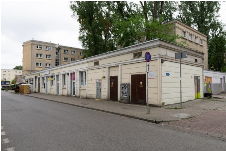
Fot. 87. ul. Nowolipie 23, pawilon handlowy, widok od strony ulicy
