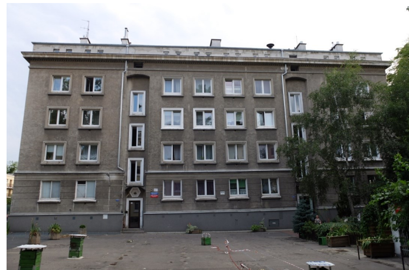
Fot. 56. ul. Smocza 4, widok od strony dziedzińca
