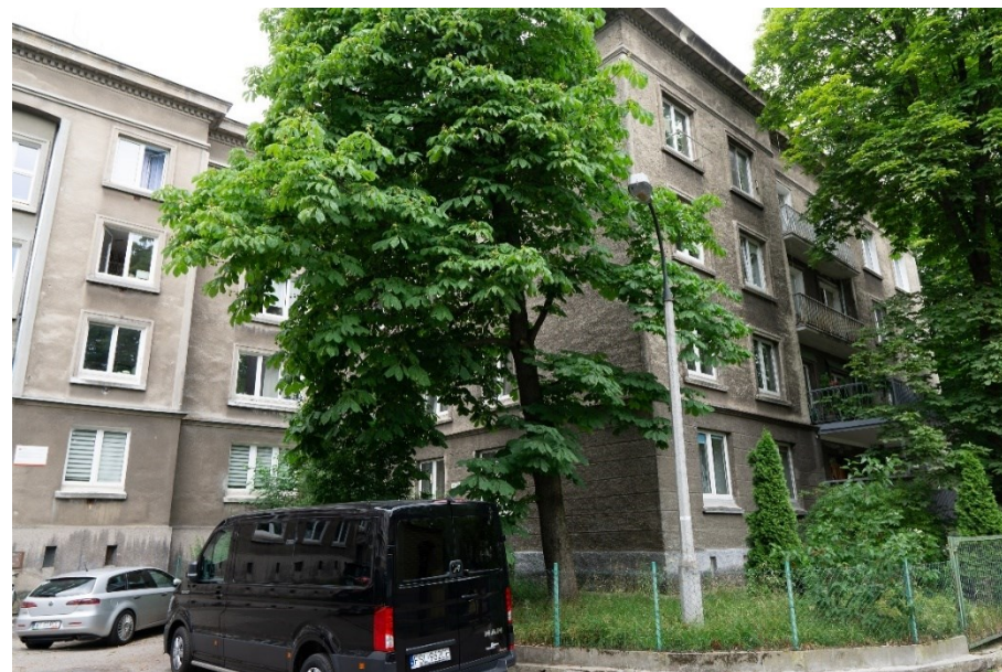
Fot. 24 ul. Nowolipie 26B, widok od strony drogi wewnętrznej
