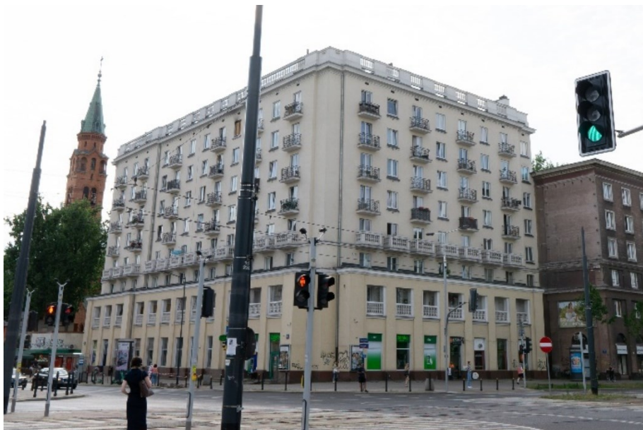
Fot. 29 ul. Nowolipki 14, widok od strony zbiegu al. Jana Pawła II i Nowolipki
