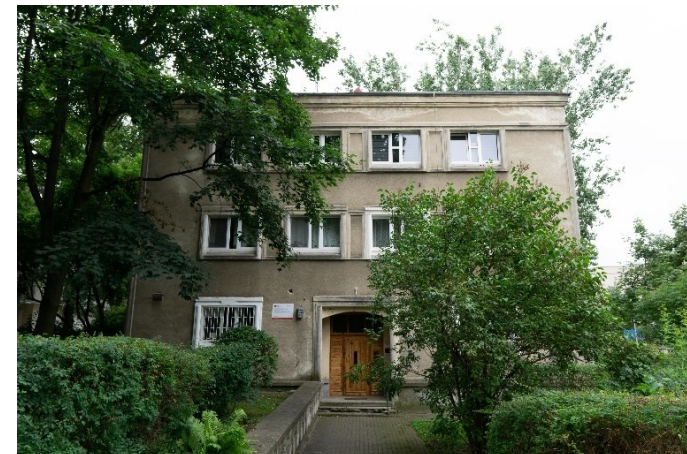
Fot. 77. ul. Nowolipie 27b, widok od strony wewnętrznego skweru
