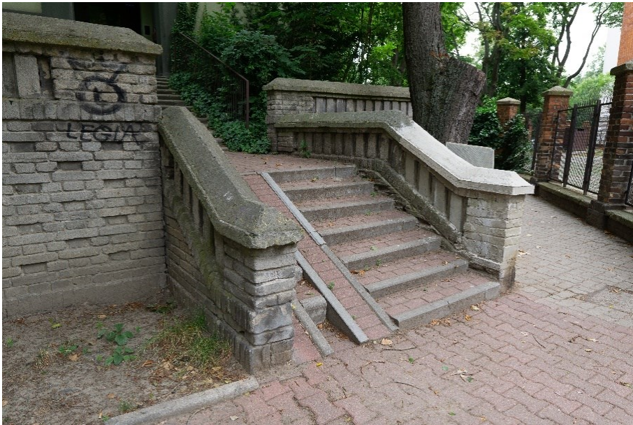
Fot. 89. ul. Dzielna 11, schody wejściowe na górny taras
