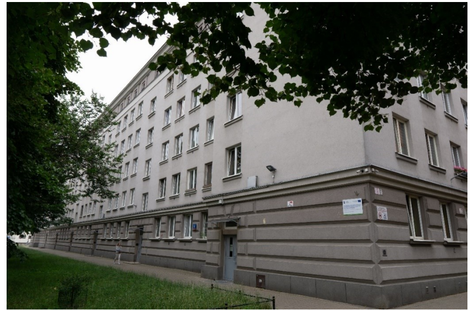
Fot. 62. ul. Dzielna 9, widok od strony ulicy
