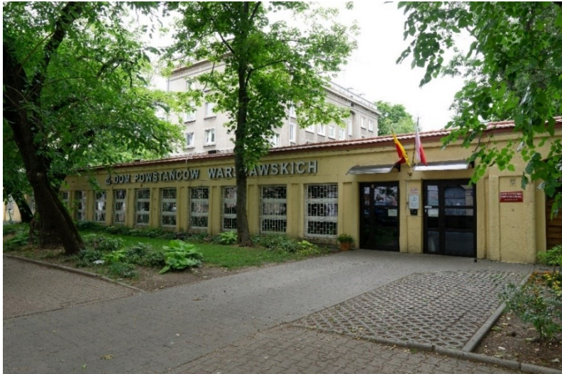
Fot. 85. ul. Nowolipie 22, pawilon, ośrodek kultury, widok od strony ulicy
