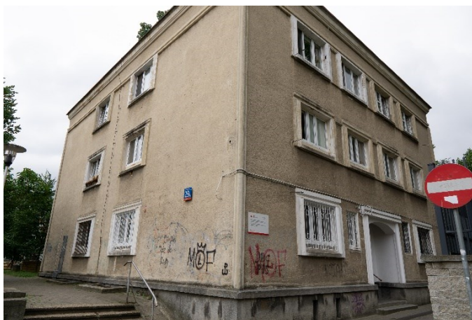
Fot. 79. ul. Nowolipie 29A, widok od strony drogi wewnętrznej
