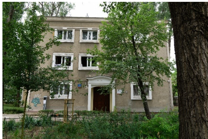
Fot. 73. ul. Nowolipie 23B, widok od strony wewnętrznego skweru
