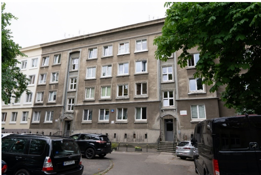
Fot. 23 ul. Nowolipie 26A, widok od strony drogi wewnętrznej
