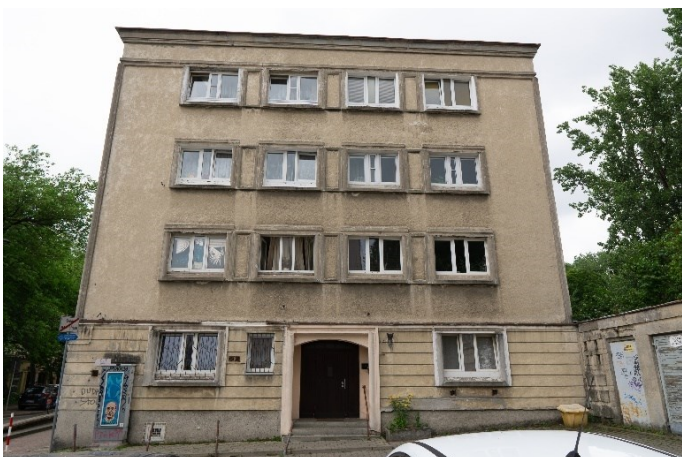
Fot. 78. ul. Nowolipie 29, widok od strony drogi wewnętrznej
