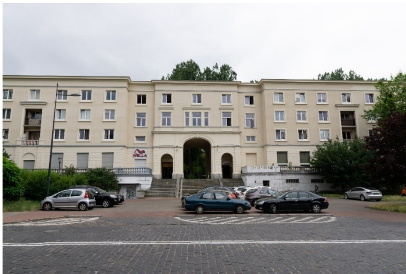
Fot. 53. ul. Smocza 1, widok od strony ulicy
