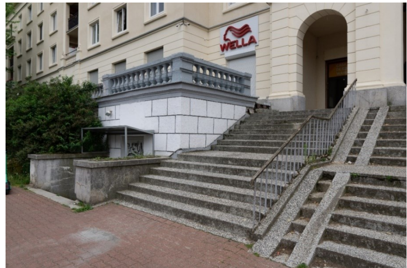
Fot. 96. ul. Smocza 1, schody wejściowe na górny taras, balustrada, widok od strony ulicy
