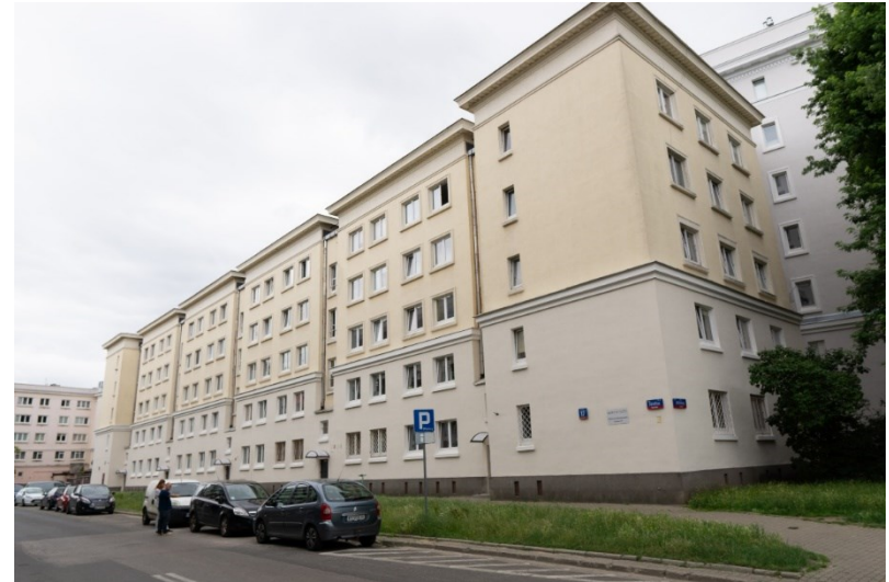
Fot. 66 ul. Dzielna 17, widok od strony ulicy
