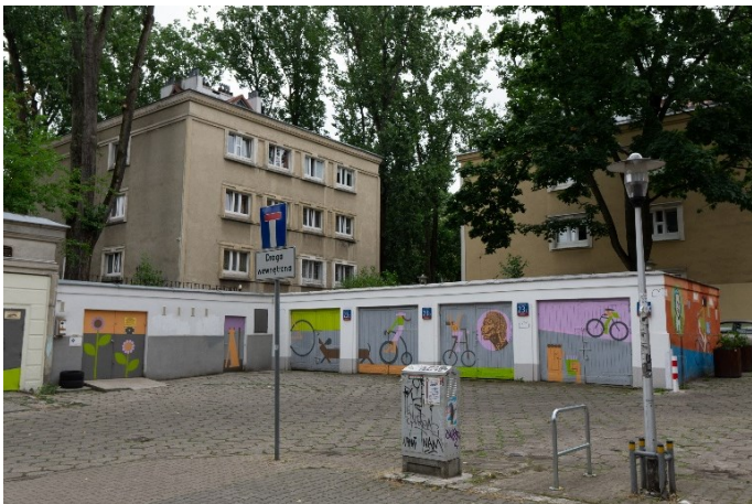
Fot. 97. ul. Nowolipie 23C do 23F, budynki garażowe
