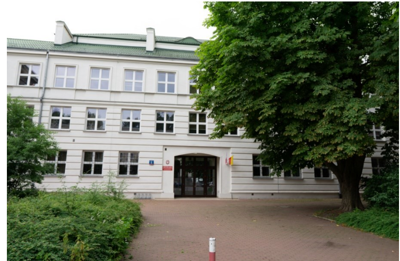
Fot. 58. ul. Smocza 6, Państwowe Liceum Plastyczne, widok od strony dziedzińca frontowego
