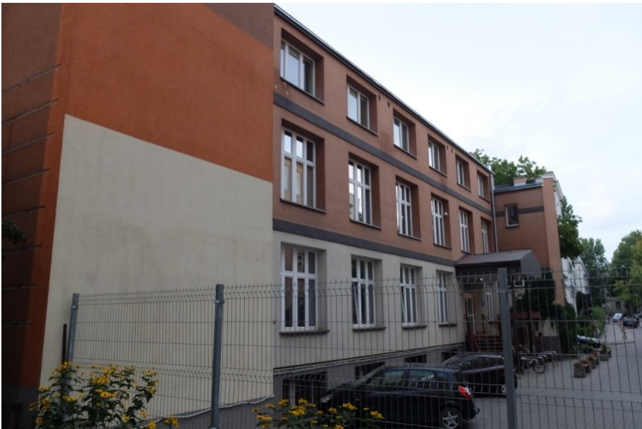
Fot. 107. ul. Wolność 2B, oficyna fabryczna, widok od strony drogi wewnętrznej
