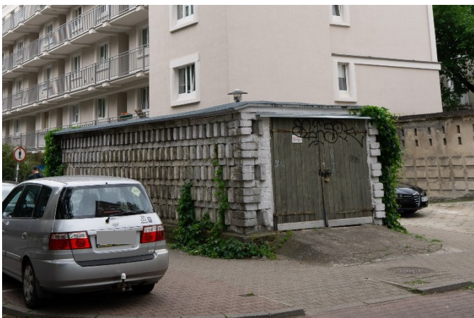
Fot. 100. ul. Nowolipie 25, budynki garażowe
