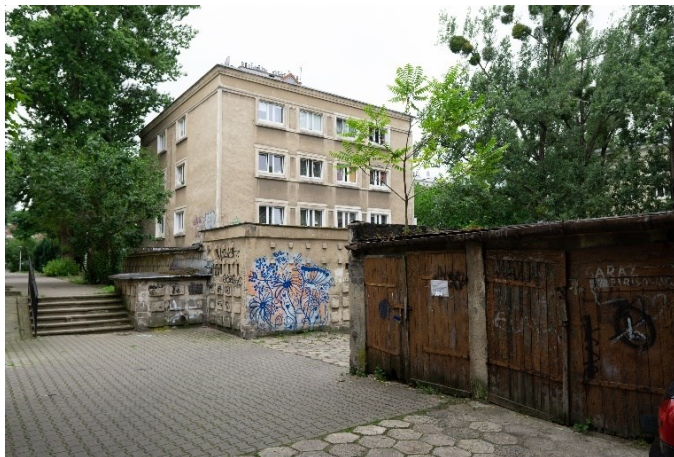
Fot. 98. ul. Nowolipie, budynki garażowe,
