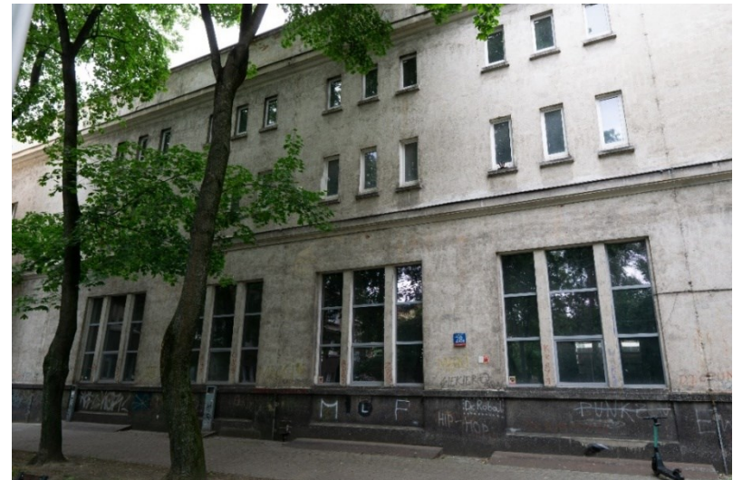
Fot. 88. ul. Nowolipki 28B, dawna kotłownia, widok od strony dziedzińca
