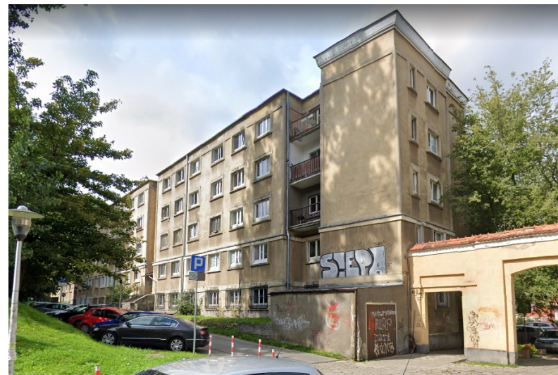
Fot. 34 ul. Nowolipki 21, widok od strony drogi wewnętrznej
