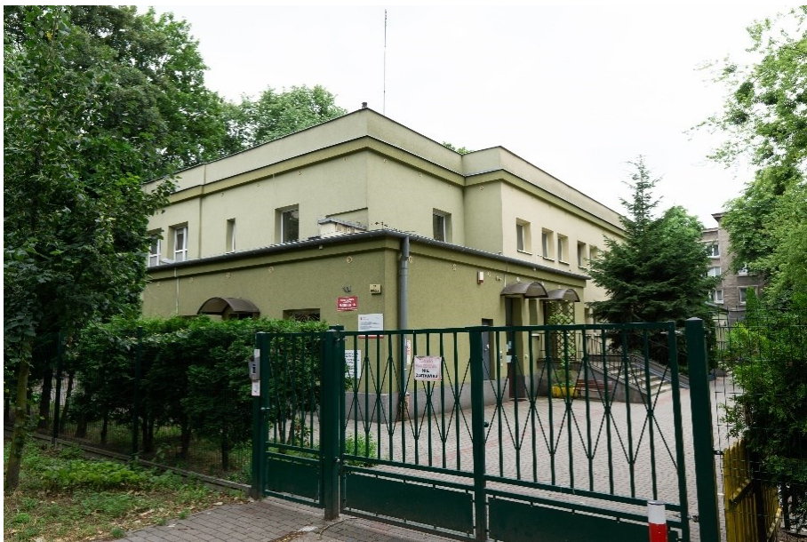
Fot. 81. ul. Smocza 1A, Żłobek nr 18, widok od strony drogi wewnętrznej
