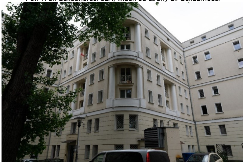
Fot. 3 al. „Solidarności” 82A, widok od strony dziedzińca
