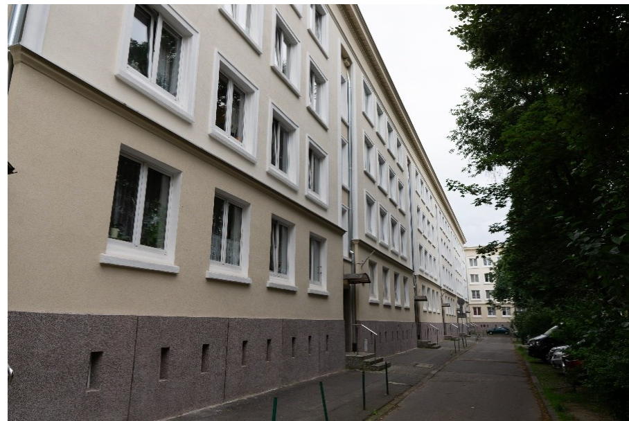
Fot. 22 ul. Nowolipie 26, widok od strony drogi wewnętrznej
