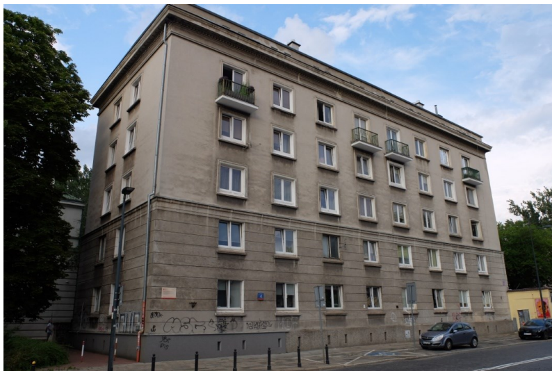
Fot. 55. ul. Smocza 4, widok od strony ulicy
