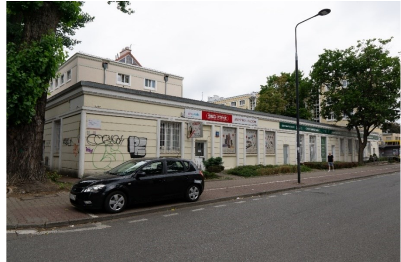
Fot. 86. ul. Nowolipie 18, pawilon handlowy, widok od strony ulicy
