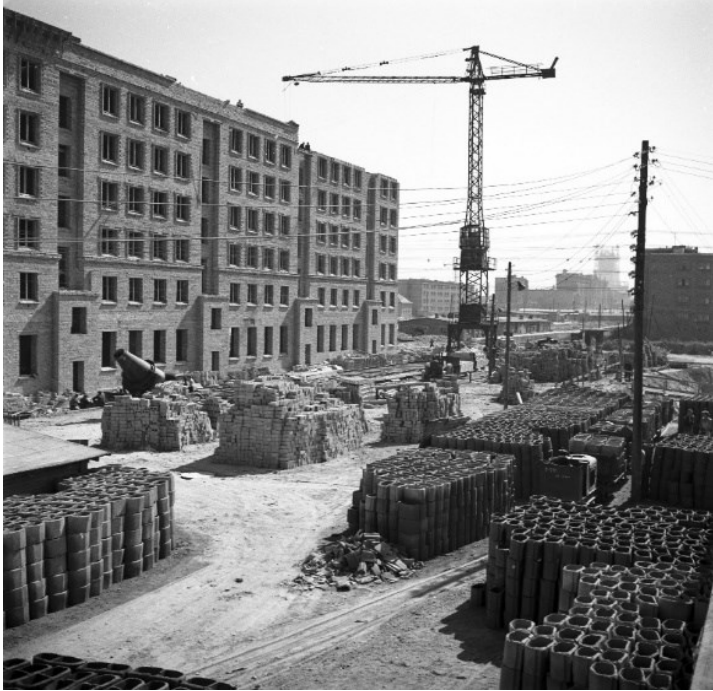
Il. 31. ul. Dzielna 7B - teren budowy, 1953, Archiwum fotograficzne Zbyszka Siemaszki, Narodowe Archiwum Cyfrowe
