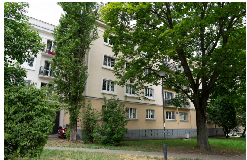
Fot. 52 ul. Nowolipki 27A i 27B, widok od strony ul. Żelaznej
