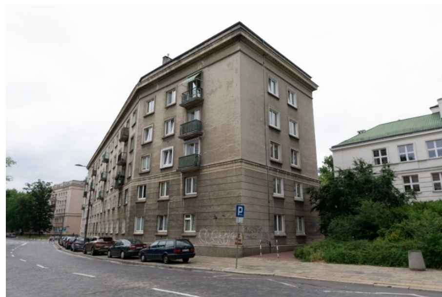
Fot. 40 ul. Nowolipki 23, widok od strony ul. Smoczej
