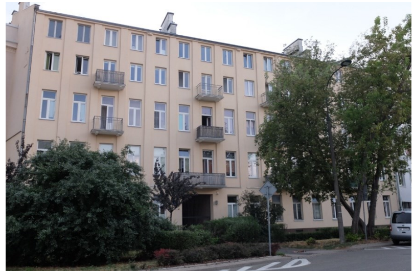
Fot. 106. ul. Wolność 2A, kamienica wraz z oficynami, widok os strony ulicy
