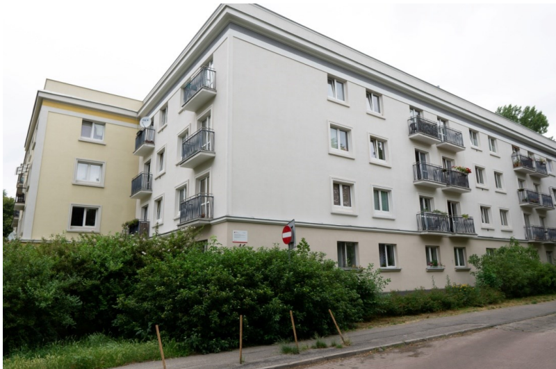
Fot. 51 ul. Nowolipki 25A i 25B, widok od strony ul. Żelaznej
