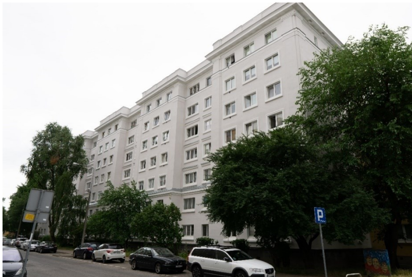
Fot. 67. ul. Dzielna 17B, widok od strony ulicy
