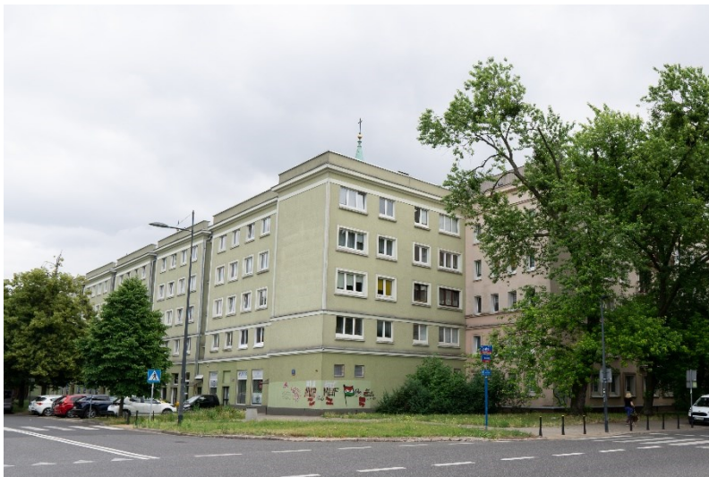
Fot. 63. ul. Dzielna 11, widok od strony ulicy
