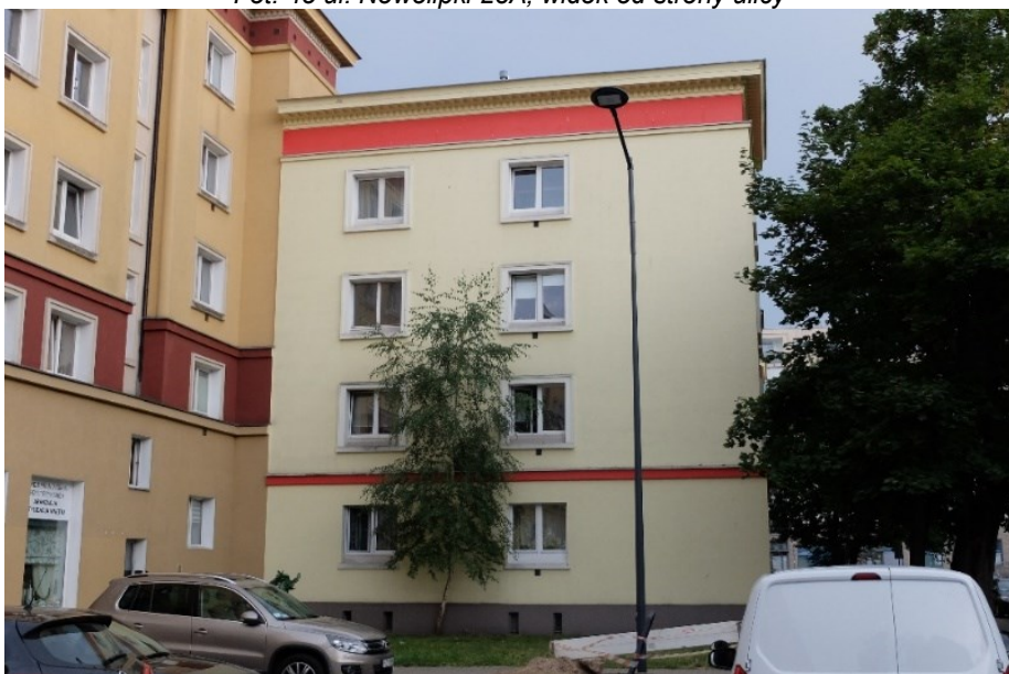
Fot. 47 ul. Nowolipki 29, elewacja boczna, widok od strony ulicy
