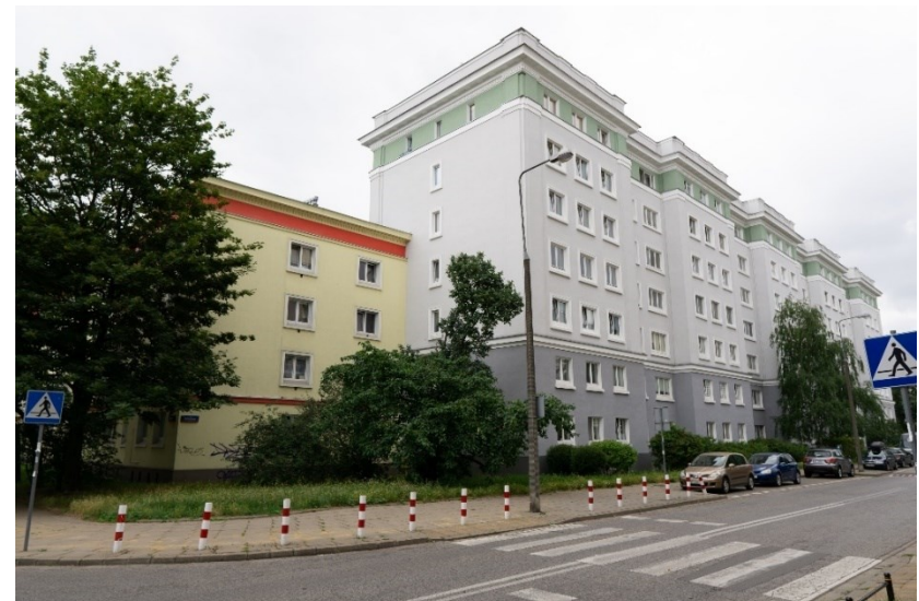
Fot. 68. ul. Nowolipki 29 i Nowolipki 29A, widok od strony ulicy
