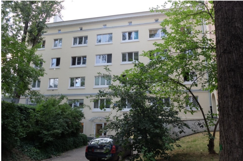
Fot. 17 ul. Nowolipie 22A, widok od strony ulicy
