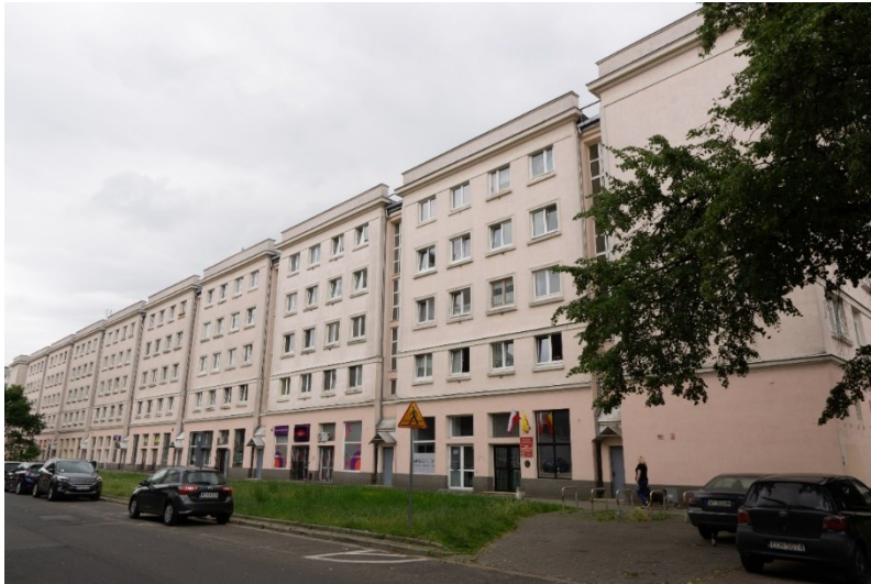
Fot. 65. ul. Dzielna 15, widok od strony ulicy
