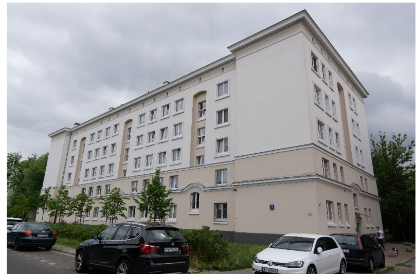
Fot. 64. ul. Dzielna 13, widok od strony ulicy
