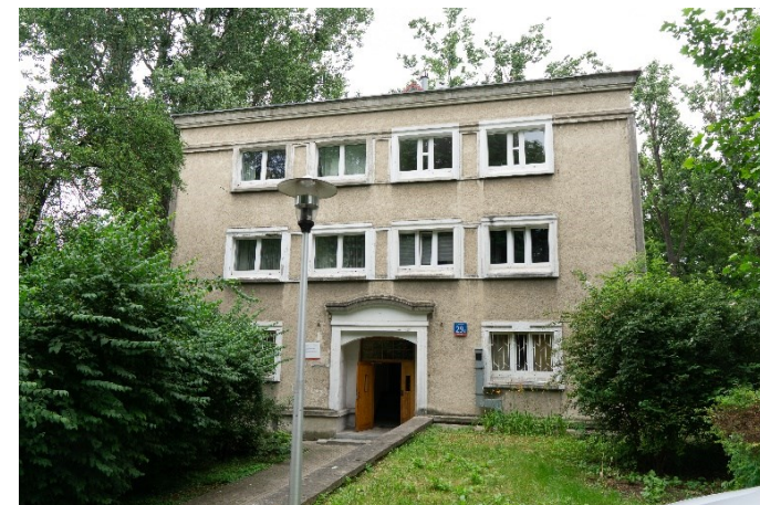
Fot. 80. ul. Nowolipie 29B, widok od strony wewnętrznego skweru
