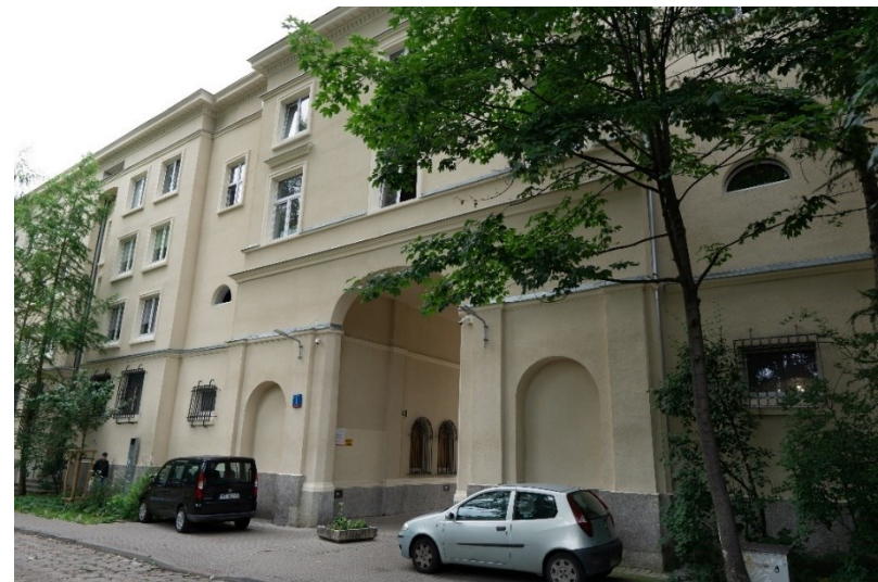
Fot. 54. ul. Smocza 1, widok od strony dziedzińca
