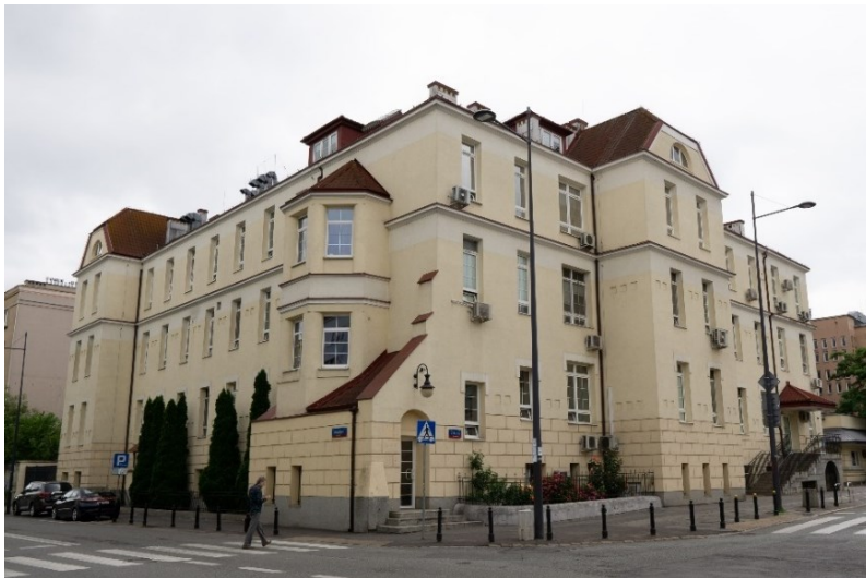
Fot. 105. ul. Żelazna 90, Szpital Specjalistyczny św. Zofii, widok od strony skrzyżowania ulic Żelaznej i Nowolipia
