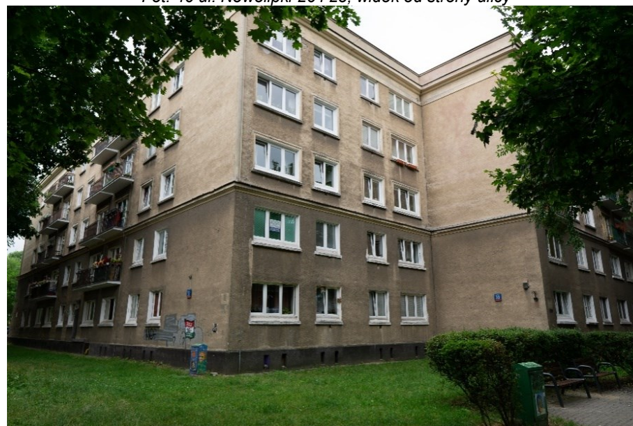
Fot. 48 ul. Nowolipki 30 i 32, widok od strony ulic
